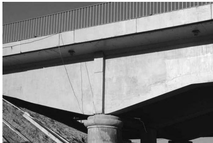
Рисунок 27 - Отремонтированное пролетное строение
