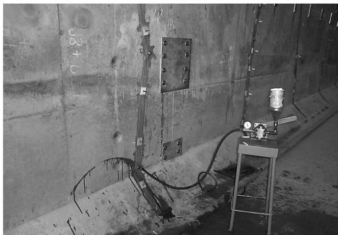
Рисунок 39 - Инъектирование трещин по высоконапорной технологии
