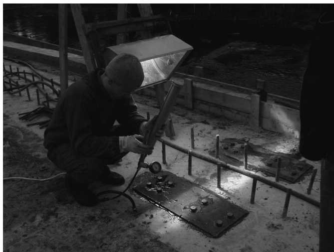
Рисунок 38 - Инъекция трещины ручным насосом
