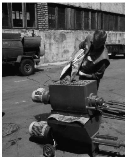
Рисунок 12 - Приготовление ремонтных смесей на различном оборудовании: а) в бетономешалке; б) с помощью дрели с насадкой.
