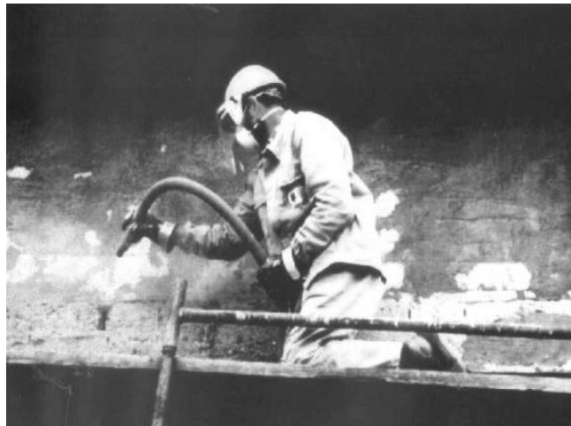
Рисунок 22 - Очистка поверхности с помощью пескоструйной установки
