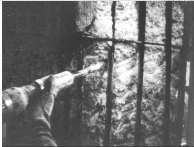
Рисунок 13 - Подготовка поверхности с помощью бучарды
