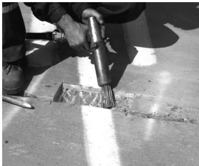
Рисунок 13 - Подготовка поверхности с помощью бучарды
