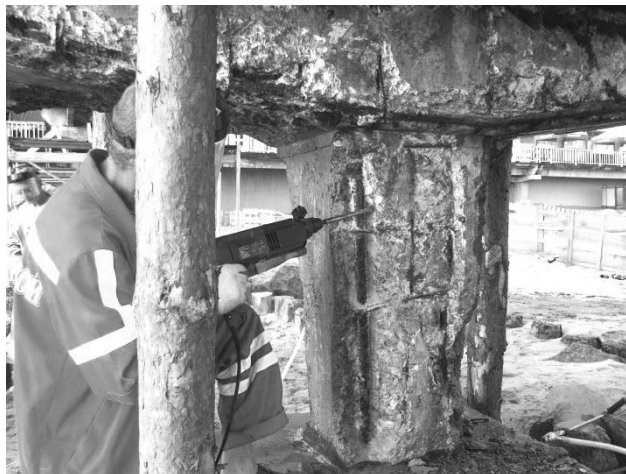
Рисунок 20 - Подготовка бетонной поверхности опоры с помощью перфоратора
