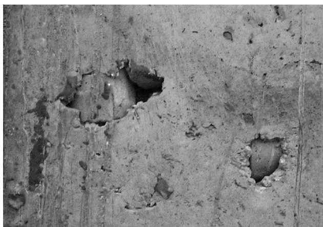
Рисунок 5 - Зависание бетонной смеси в зоне «сухарей»
