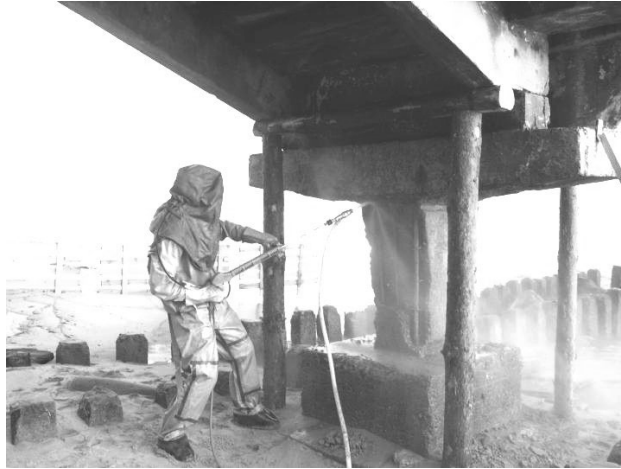
Рисунок 21 - Очистка поверхности с помощью водопескоструйной установки
