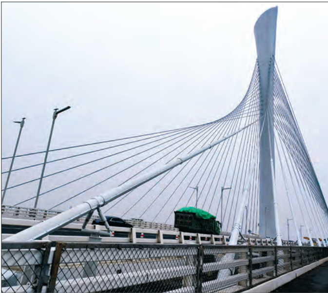
Мост через реку Хутуо, Китай
