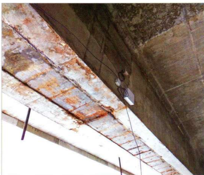
Мониторинг строящегося моста ЦКАД через р. Москву
