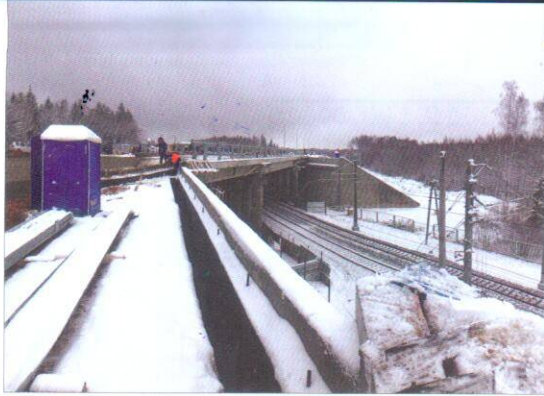
Рис. 5. Отрылок опоры ОК1 правого путепровода
